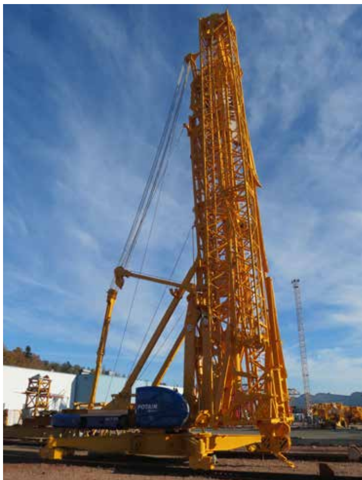
▼ Basculamento idraulico della torre
