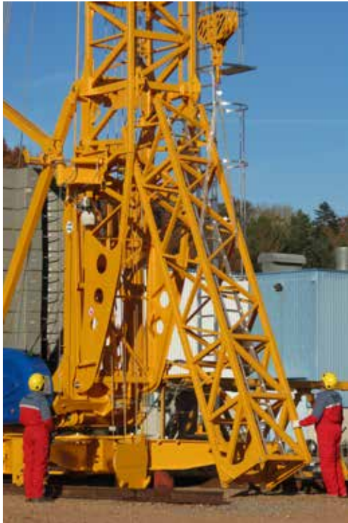
^ Telescopaggio tramite inserimento di elementi di prolunga
