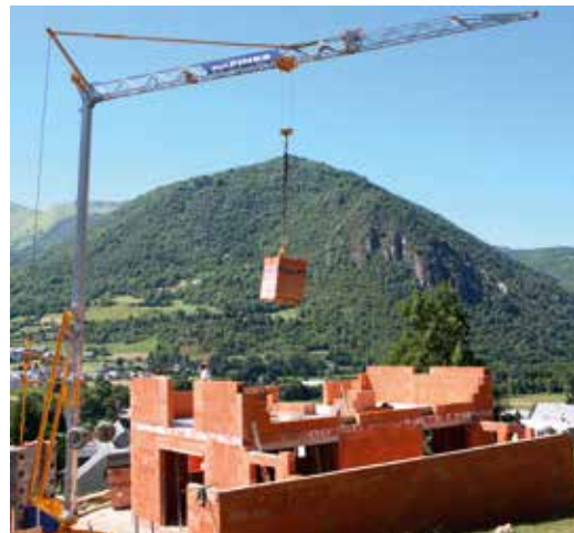
Il raggio d'azione copre l'intero cantiere.
